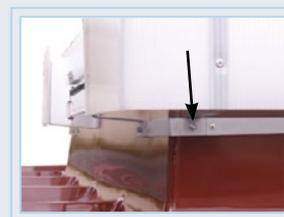
**2.** Emboîter les deux déflecteurs sur les supports situés sur la costière, puis les fixer avec des vis autoforeuses 6,3 x 25 mm.
