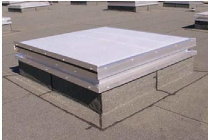
4- Fixer la coiffante au niveau de la retombée. Les fixations seront adaptées aux types de support et auront un écartement maximal de 350mm.
